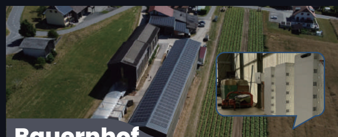
Fabrik Belgien 440 kW AC-Ausgang | 1013 kWh ESS-Kapazität
